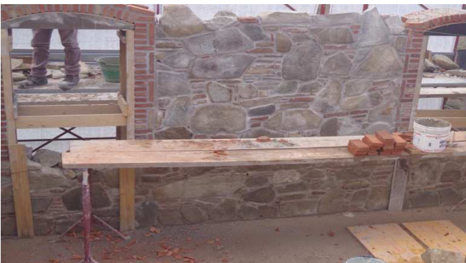
Figg. 3 - Tecnica dello “Scuci e Cuci” e dell’ “Anastilosi” per il ripristino di lesioni passanti; rifacimento della muratura portante originaria
