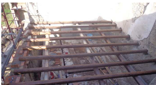
Figg. 5 - Passaggio da sistema spingente a sistema poggiate
