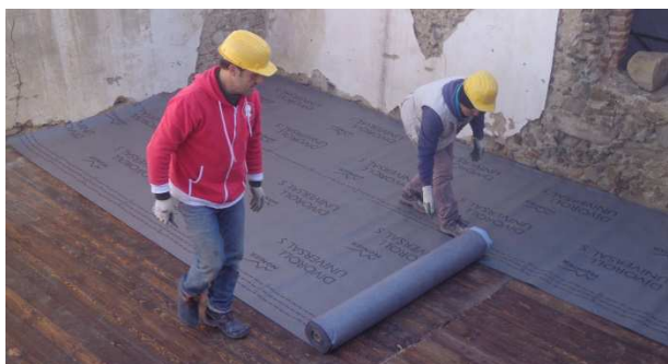
Figg. 6 - Realizzazione di solai lignei
