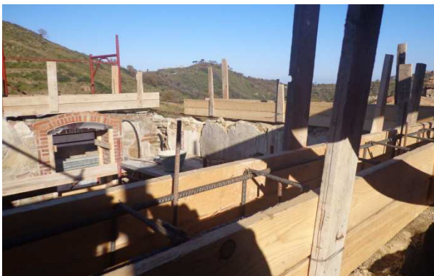
Figg. 4 - Inserimento di cordoli armati; l’orditura primaria viene opportunamente ancorata ai setti portanti fungendo da catene/tiranti
