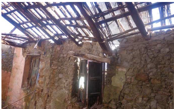
Figg. 5 - Passaggio da sistema spingente a sistema poggiate
